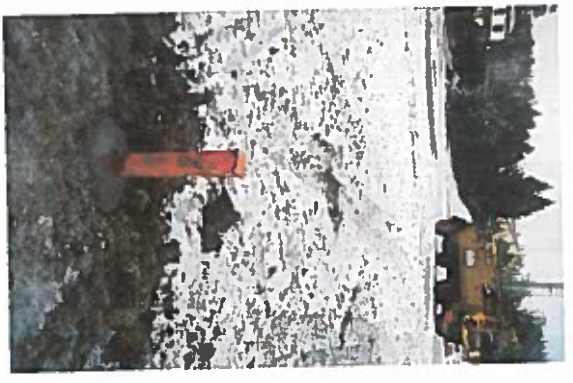
Pose du piézomètre PZ1 en limite ouest du site & vue du piézomètre achevé (avec bouche à clef orange)
